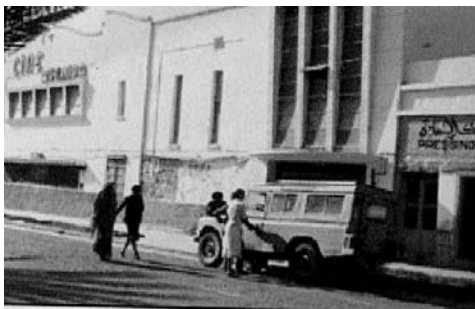
El cine Avenida. Sidi Ifn
